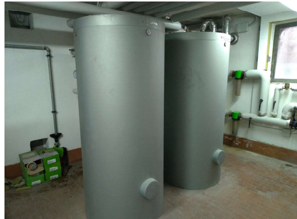
Fig. 2 – coppia serbatoi di accumulo (boilers) acqua calda sanitaria
