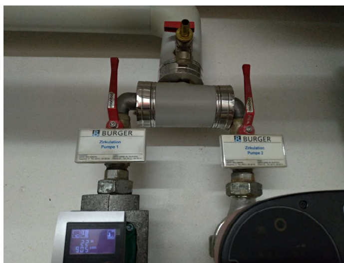
Fig 5 - pompe ricircolo circuito acqua calda sanitaria
